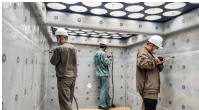
Verklebung auf Stahl
