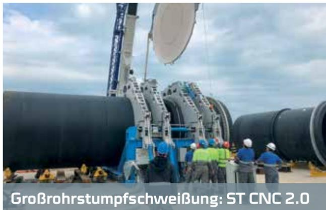
Großrohrstumpfschweißung: ST CNC 2.0
