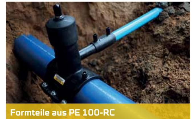
Formteile aus PE 100-RC
